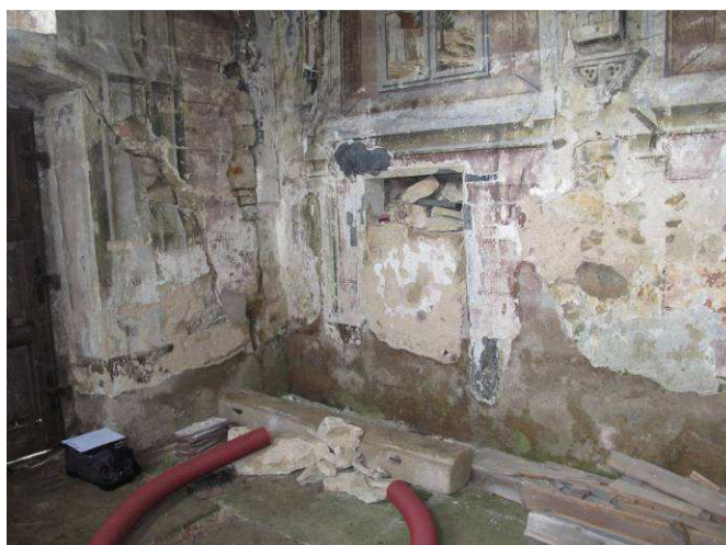
Foto č. 12 – statická porucha v čelní stěně
