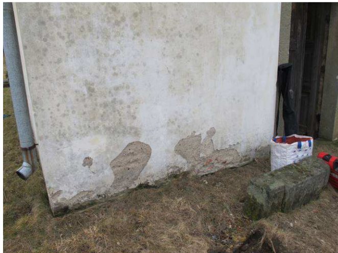
Foto č. 2 – nedostatečné odvodnění z dešťového svodu a vznik biotetického napadení na fasádě
