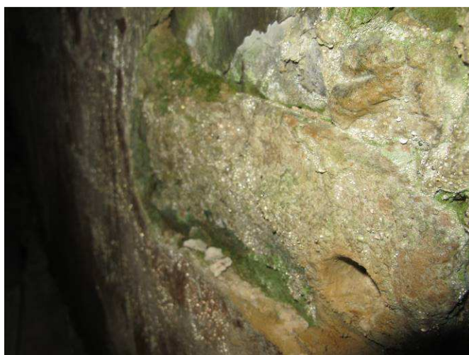
Foto č. 16 – detail kondenzace na obnaženém kamenném zdivu
