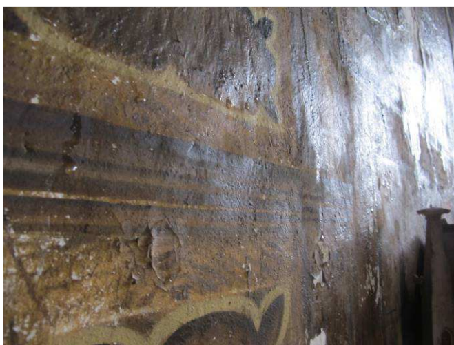
Foto č. 15 – detail kondenzace na nástěnné malbě
