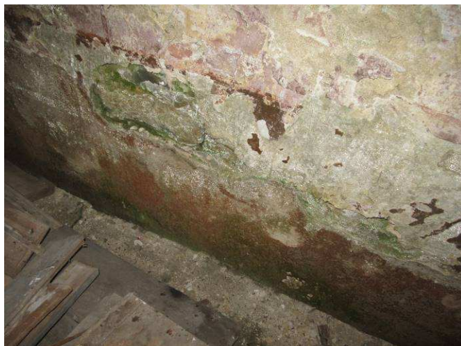
Foto č. 14 – rozsáhlé kondenzace na povrchu při dosažení rosného bodu
