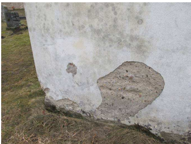
Foto č. 3 – detail degradace omítky s vyšším podílem cementového pojiva
