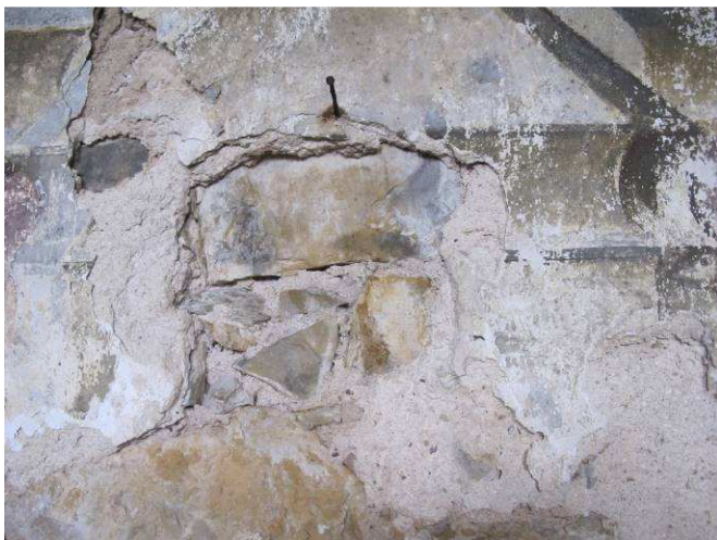
Foto č. 13 – detail provedení zdiva z kamenných materiálů (pískovec, opuka)
