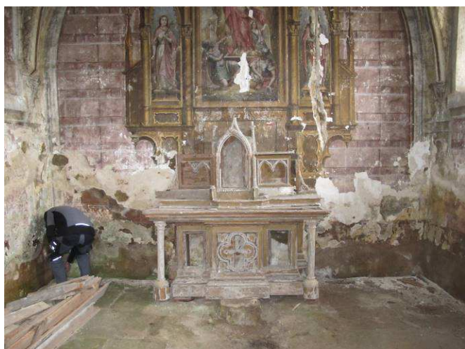
Foto č. 11 – značný rozsah poškození omítek a povrchových úprav maleb a způsob provedení dlažby
